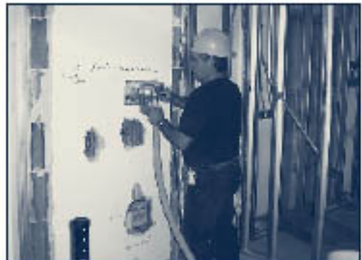
Un travailleur utilise la scie munie du système d'aspiration à la source.
